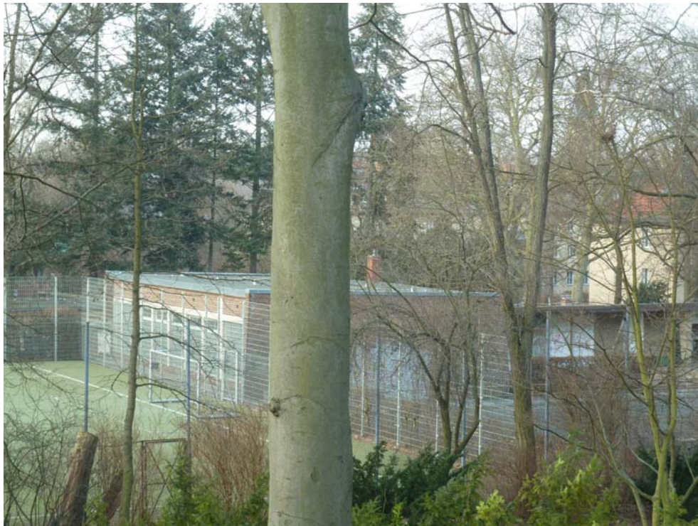
Gymnastikhalle und Sanitärtrakt, vom angrenzenden Park aus gesehen
